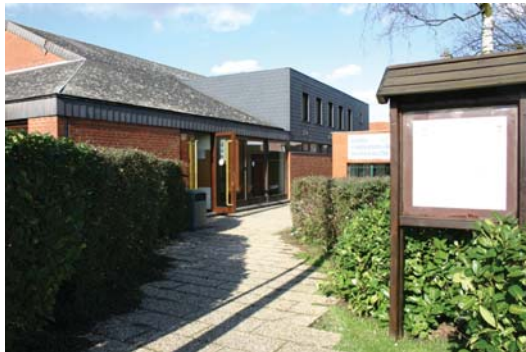
Amélioration de l'électricité et des toilettes à la salle polyvalente.
