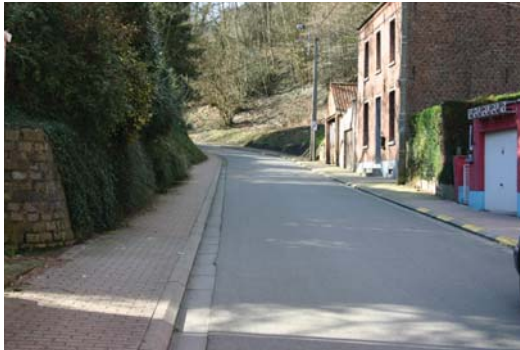
Entretien des trottoirs – Rue Haute.
