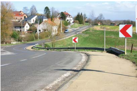
Entretien des trottoirs sur la N 280.
