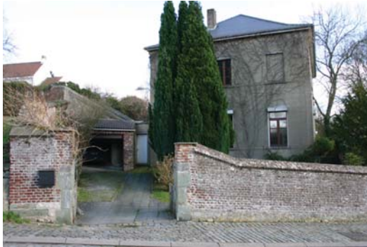
Travaux dans la Cure d'Haut-Ittre.
