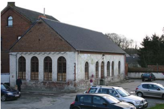
La toiture de la salle Planchette.
